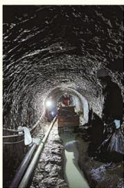
農業用水のための水路トンネルの補修工事。冬に補修し、春からの畑仕事に備える(写真集『インフラメンテナンス』より)
